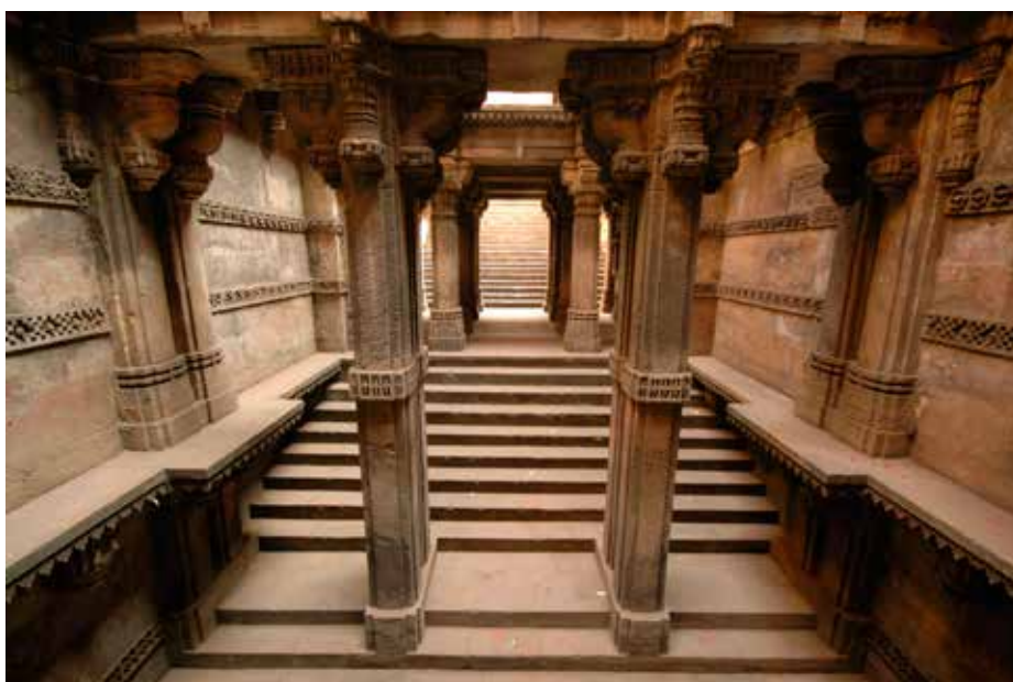
תמונה 5. מגדלי הפאבליון בנויים קומות-קומות בשיטת העמוד והקורה ונמצאים בדרך כלל במרחקים שווים זה מזה. ראשם של המגדלים מגיע עד מפלס הקרקע שמחוץ לבאר. בתמונה: מגדלי פאבליון ב-Dada Hārīr vāv. צילום: יותם יעקבסון.
