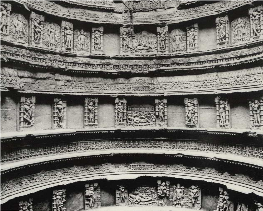
12. צלמי וישנו ששאשאינה בפיר הבאר. התחתון: גומחה מס' 270, האמצעי: גומחה 289, העליון: גומחה מס' 315. מתוך: Mankodi, עמ' 75.
